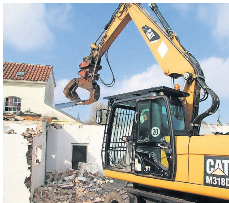
Der mit einem Sortiergreifer ausgestattete Bagger fraß sich am Donnerstag in das Haus, in dem viele Jahre ein Fahrradverleih untergebracht war.
