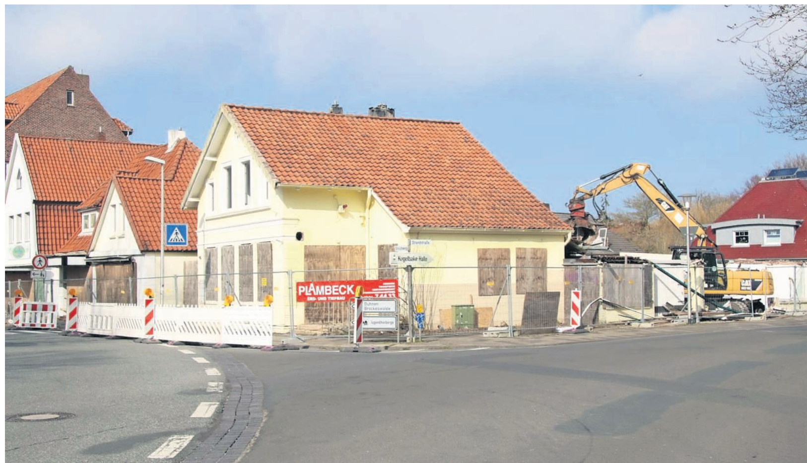
Die in die Jahre gekommene Häuserzeile am Strichweg/Ecke Strandstraße wird in den kommenden Wochen Stück für Stück verschwinden. Ein Abrißbagger der Firma Plambeck Erd- und Tiefbau ist seit Mitte der Woche dabei, die Häuser abzureißen. Fotos: Potschka
