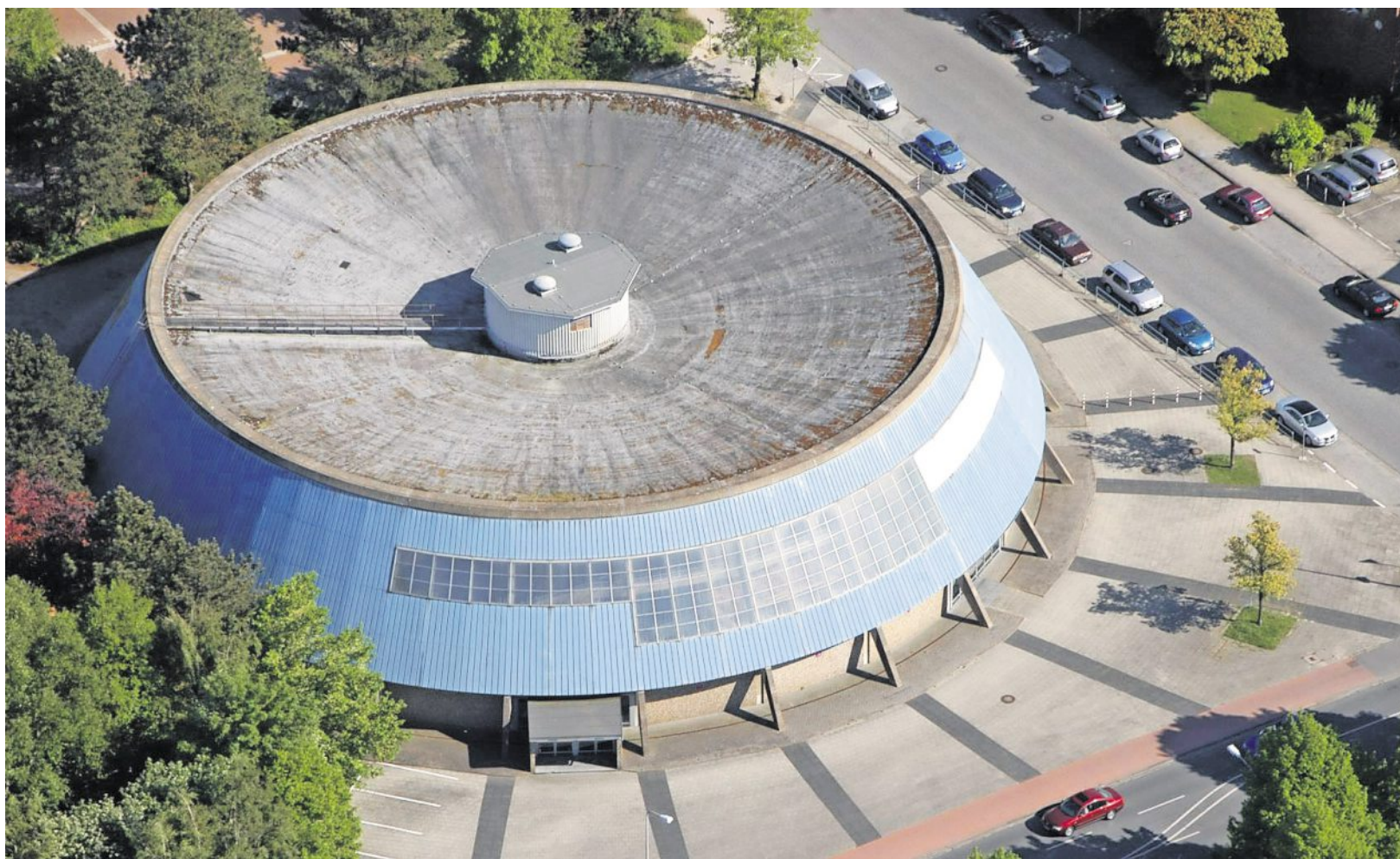
Die Rundturnhalle Cuxhaven ist ein Relikt aus der Zeit vor der Ölkrise. Spötter sagen, dass der gegenüberliegende Wochenmarkt durch die aus Metall und Glas bestehende Fassade mitbeheizt wird. Auch ist die Halle schon in der Vergangenheit mehrfach wegen gefährlicher Schneelasten auf dem Dach gesperrt worden. Insgesamt hat der Zahn der Zeit an dem runden Bauwerk genagt. Foto: Schröder
