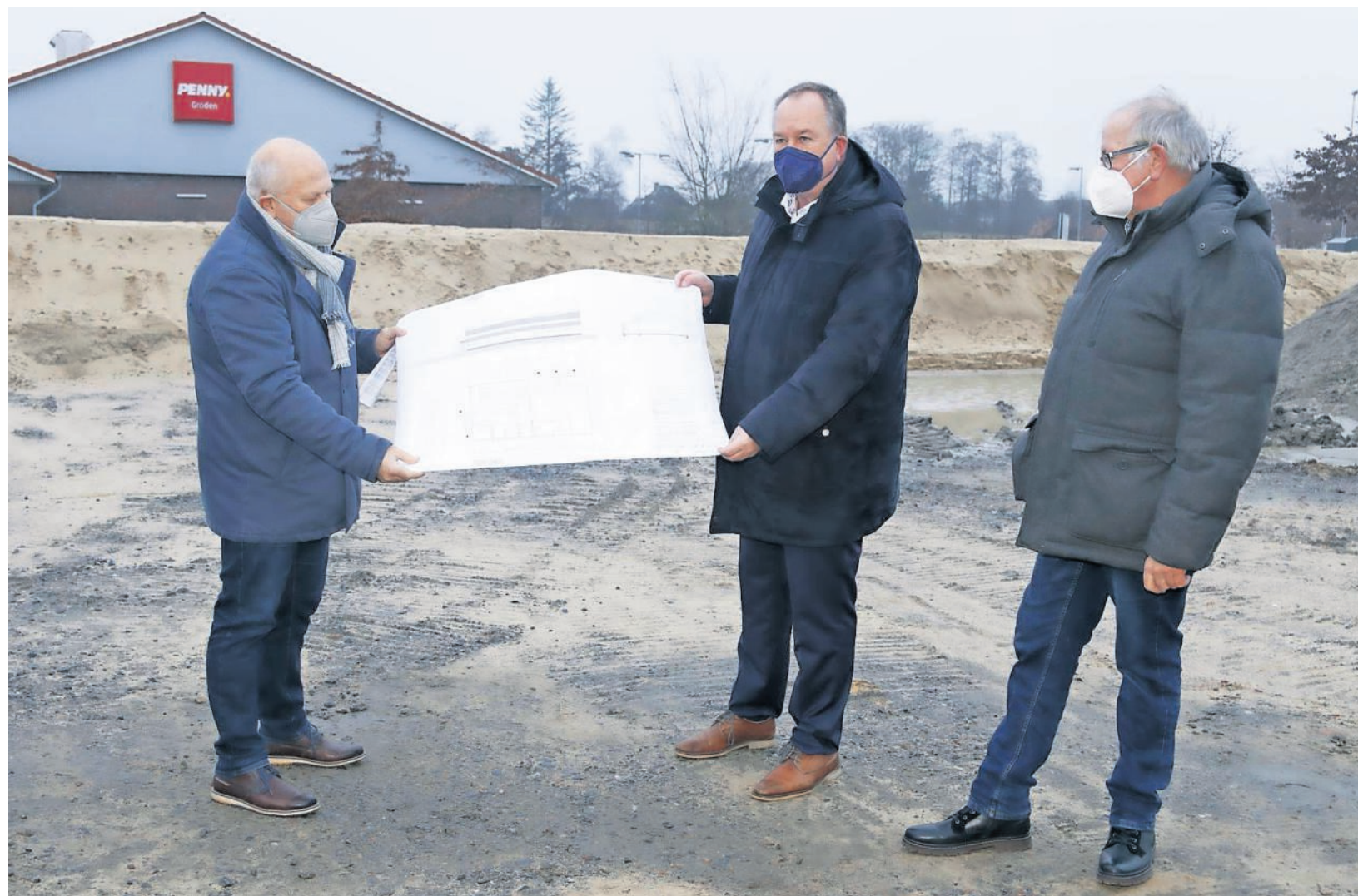
Hochbauamtsleiter Lutz Rothermundt präsentiert mit Oberbürgermeister Uwe Santjer und dem Vorsitzenden des städtischen Feuerwehrausschusses Michael Stobbe (r.) die Architektenskizze . Im Hintergrund ist die Sandaufschüttung zu sehen, die eine Flachgründung ermöglichen soll. Foto: Koppe
