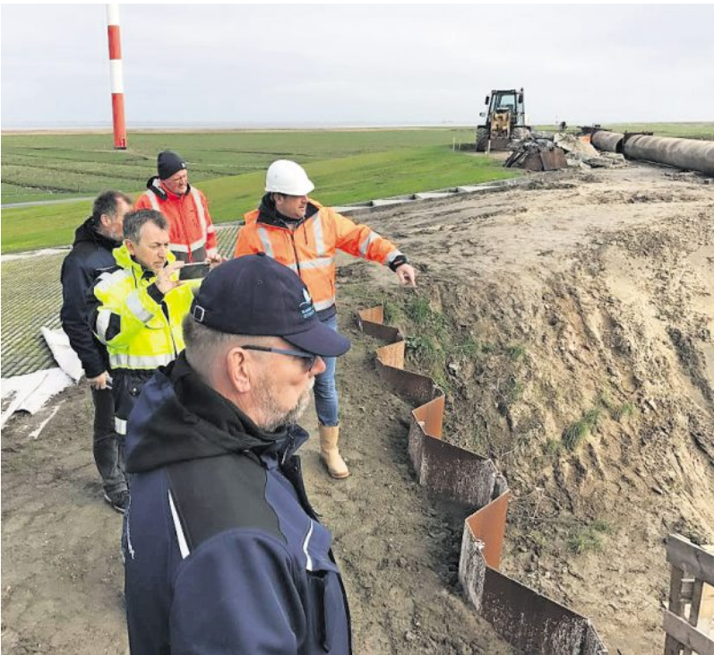
Im Deichvorland sind die Anschlüsse an das neue Schleusenbauwerk bereits komplett hergestellt.
