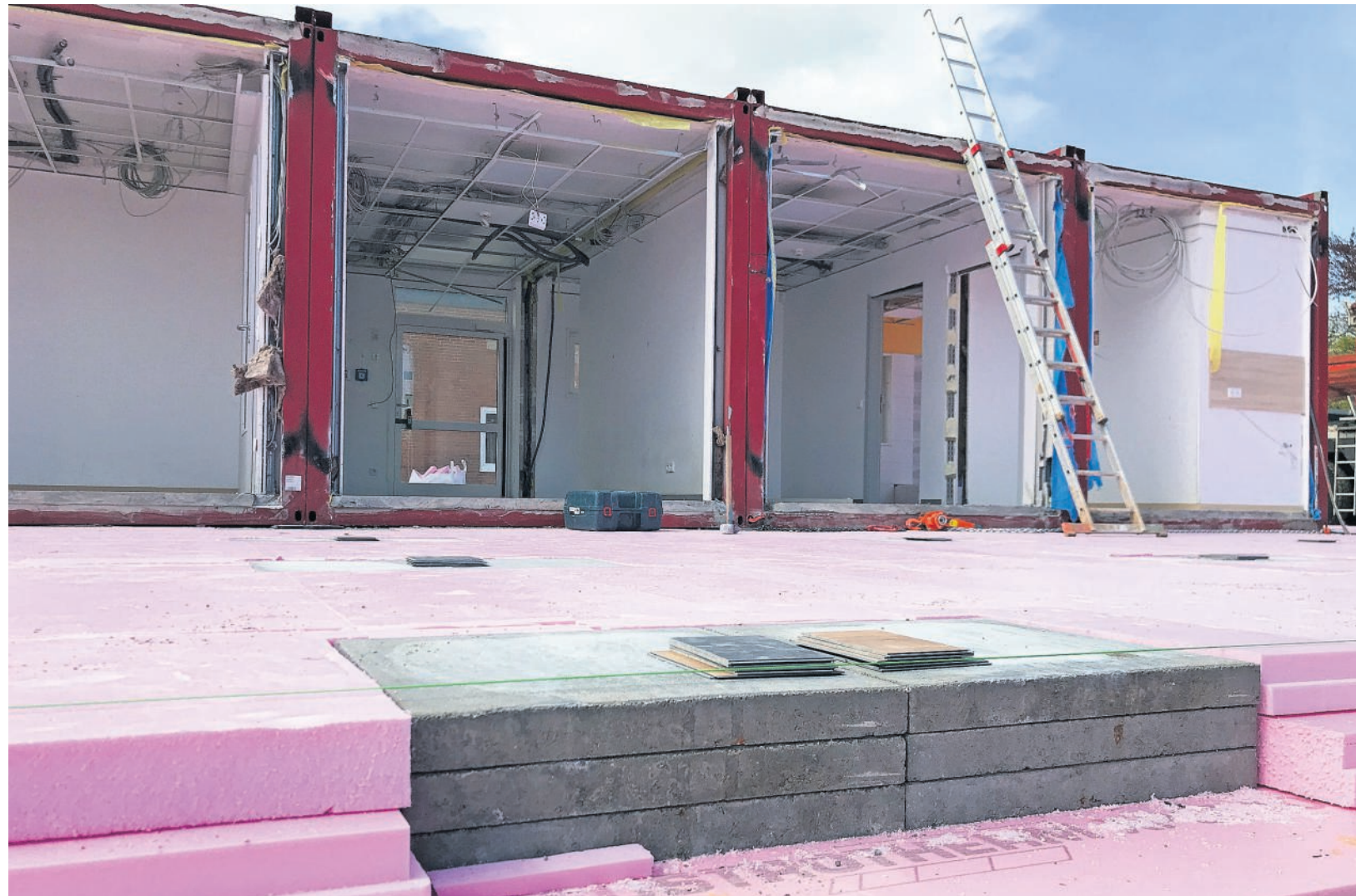
Die erste Reihe ist montiert - nun wartet das Fundament aus Styropor und Terrassenplatten auf die zweite Hälfte des Gebäudes. Fotos: Reese-Winne
