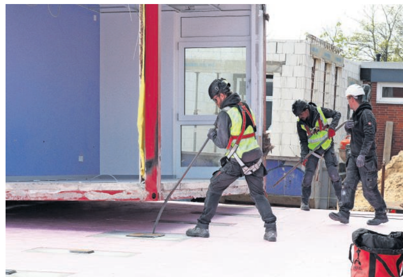
Mit Hilfe zweier Kuhfüße richten die Baufachleute jeden Container genau aus. Im Hintergrund: die Verbindung zur Bestandskita.
