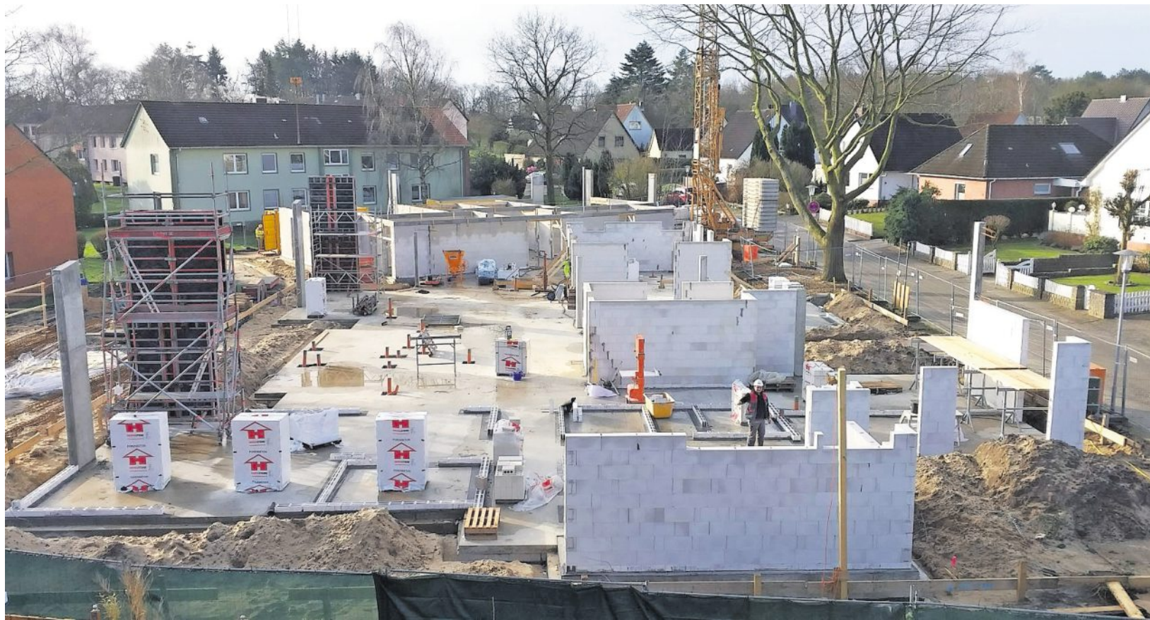
Blick von oben auf die Baustelle der DRK-Kita Kornblumenweg in Altenwalde. Dort geht es zügig voran.
