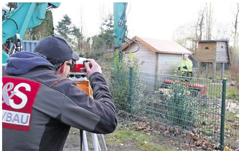
Baustart der Kindertagesstätte Emmaus: Bevor Arbeiter gestern die Spielgeräte auf dem Außengelände der Kita abbauten, nahmen Bauleiter Ulrich Harjes (l.) und sein Kollege Leonard Carstens von der Firma „C & S Massivbau“ aus Nordholz noch einige Maße.
