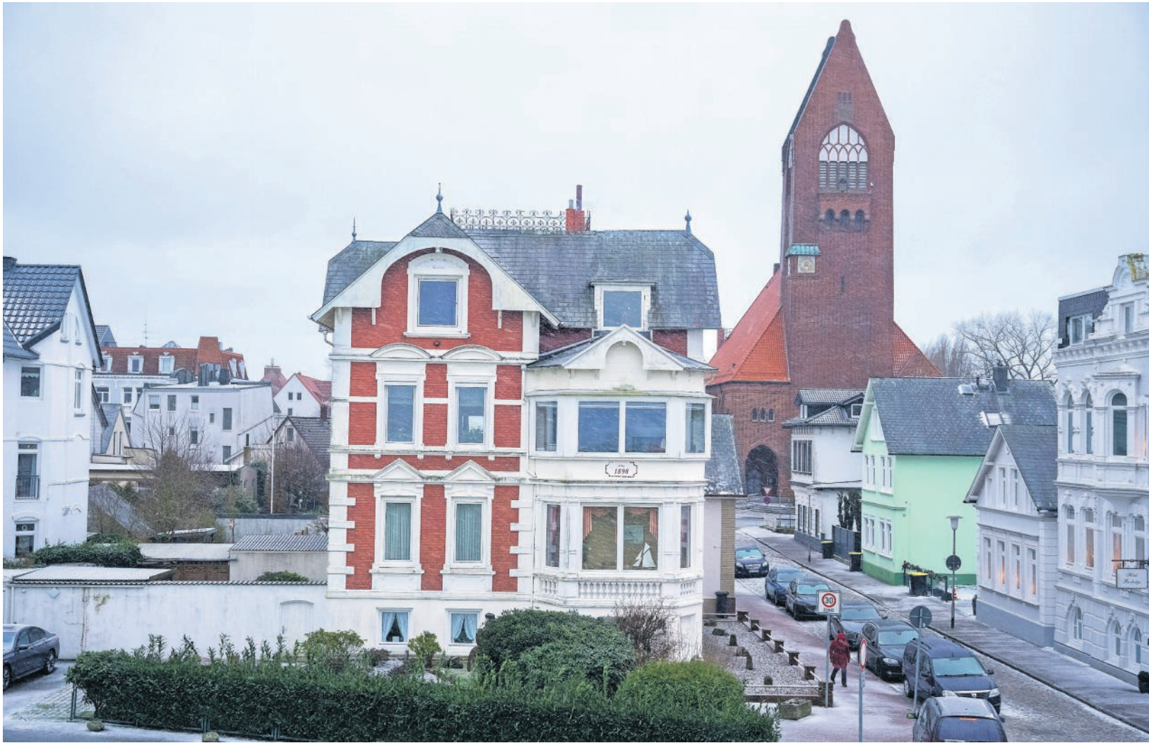
Die Villa wurde ursprünglich 1898 in aufwendiger und anspruchsvoller Massivbauweise errichtet. Die verklinkerte Außenfassade ist mit verschiedenartigen Bändern verkleidet und mit einer Putzgliederung in Formen der Renaissance versehen. Foto: Keck
