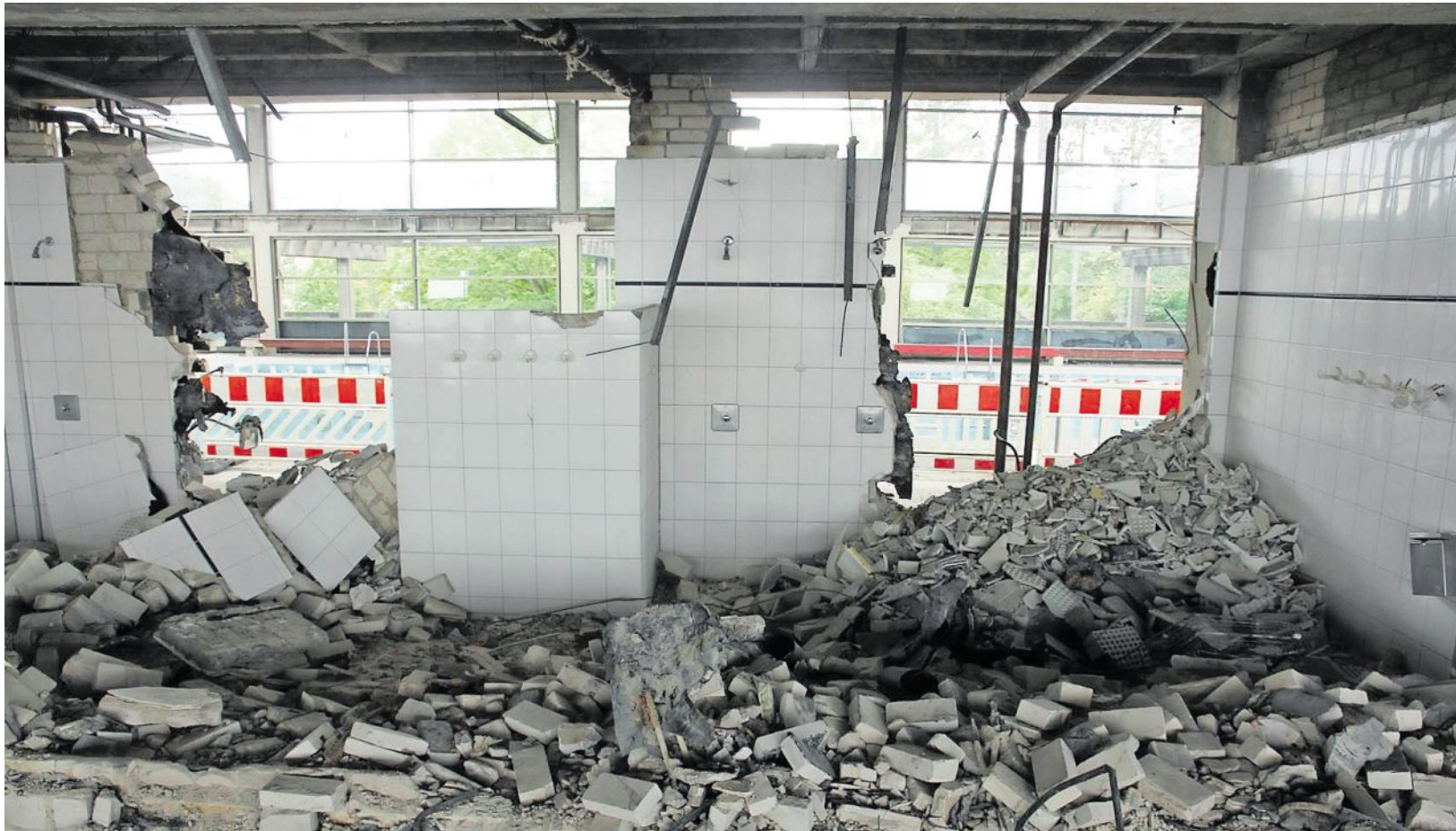
Der ehemalige Duschenbereich im Hallenbad an der Beethovenallee ist bereits ein Trümmerfeld. Das dahinter liegende Schwimmbecken ist noch weitgehend erhalten. Doch auch hier kommt bald der Abbruchbagger. Fotos: Sassen
