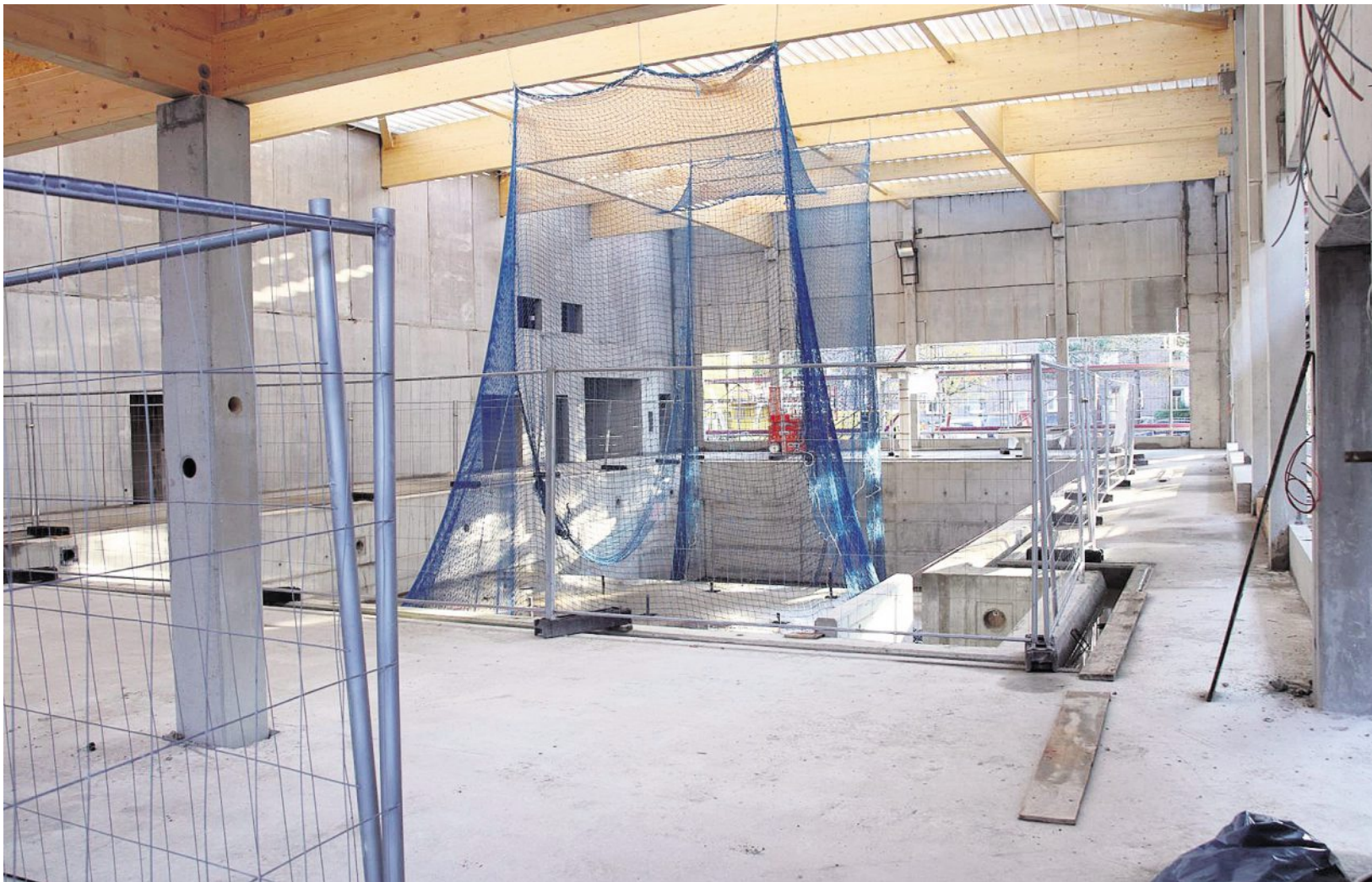
Beton dominiert gegenwärtig noch das Bild, das sich bei einem Blick in die künftige Schwimmhalle bietet. Später werden Besucher dort auf Fliesen und Verkleidungen stoßen, die einem „nordisch inspirierten“ Farbschema folgen. Die Schichtholzblätter an der Decke bleiben wie sie sind. Fotos: Koppe
