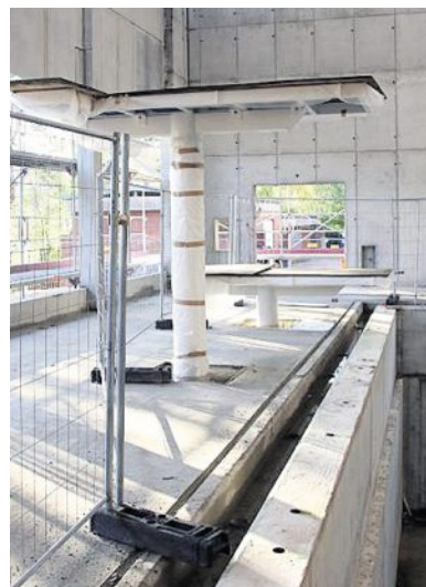
Die Sprunganlage (Drei- und Einmeterbrett) wurde bereits installiert.
