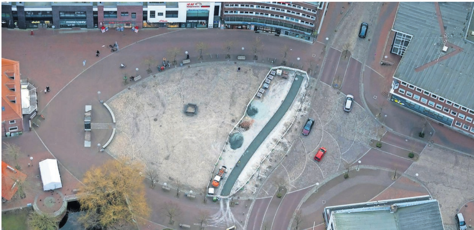
So sah der Buttplatz aus der Vogelperspektive während der Bauphase des Radweges , der den Fisch durchtrennt, aus.
