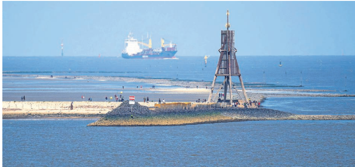
Das Cuxhavener Seezeichen Kugelbake. In der Nähe wurden jetzt erneut die Baggerarbeiten zur Elbvertiefung gestoppt. Foto: Schuldt/dpa
