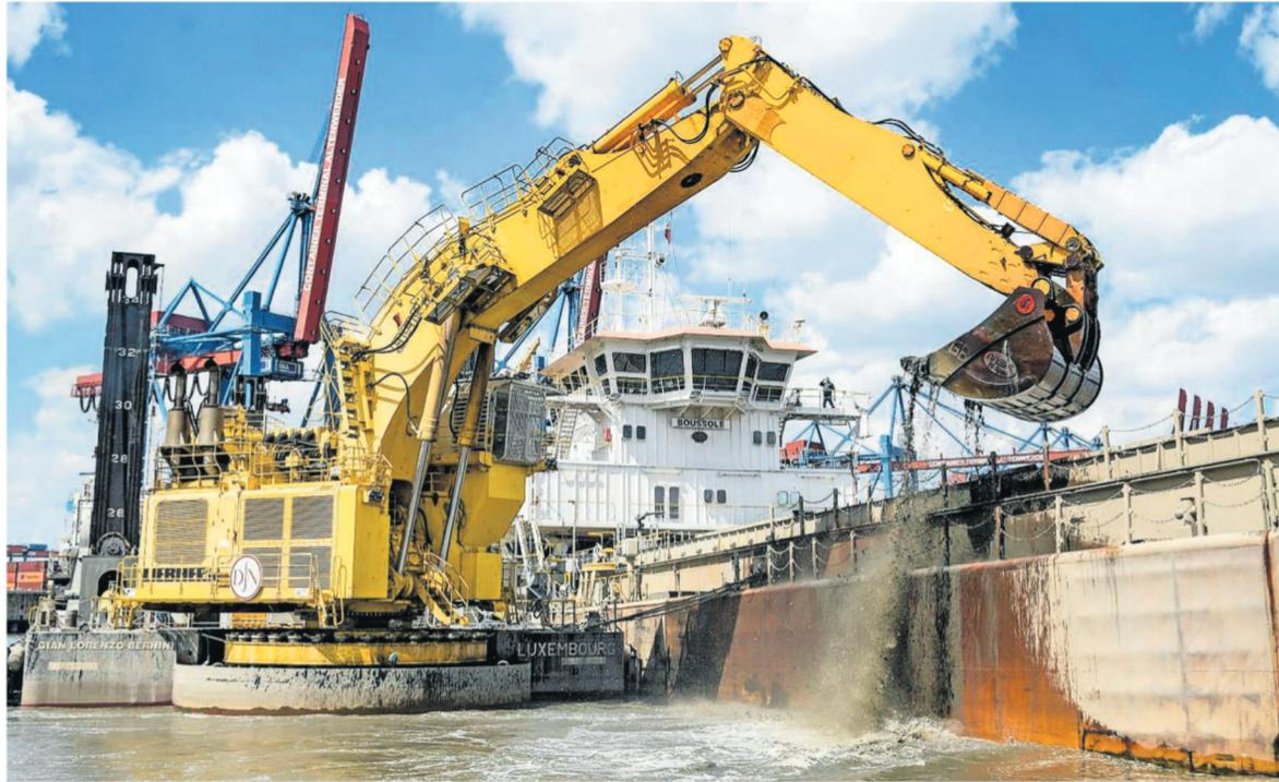
Ein Bagger holt bei Arbeiten zur Elbvertiefung **Baggergut** aus einem Hafenbecken in Hamburg. Die stetig ansteigenden Mengen an Schlick gefährden trotz Investition von gut 286 Millionen Euro allein durch die Hansestadt das Ziel, attraktiver Anlaufhafen für große Containerschiffe zu bleiben. Foto: Heimken / dpa
