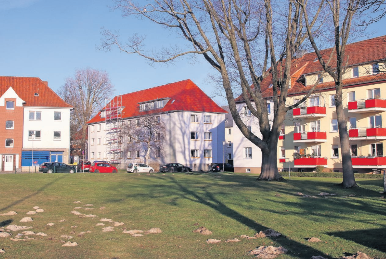
Im Bereich Wernerstraße 21 bis 25 will die Siedlung neu bauen. Der Spatenstich könnte bereits Ende des Jahres erfolgen. Foto: Koppe
