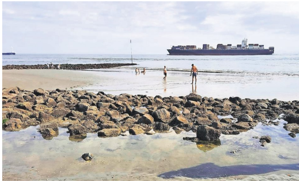
Beim Leitdamm herrscht aufgrund von Strömungen, verursacht durch die Tide und den Wellenschlag, absolutes Badeverbot! Trotz Warnhinweisen klettern immer wieder Menschen auf den Damm. Am vergangenen Wochenende vernügte sich Strandgänger sogar vor dem Damm direkt an der Fahrrinne. Fotos: Sassen / Potschka (2)
